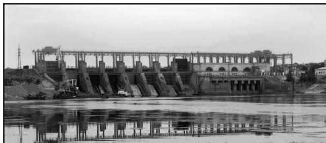
Плотина Дубоссарской ГЭС
