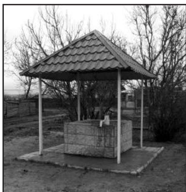
Фото 5, 6. Колодец по переулку Чапаева до и после реконструкции
