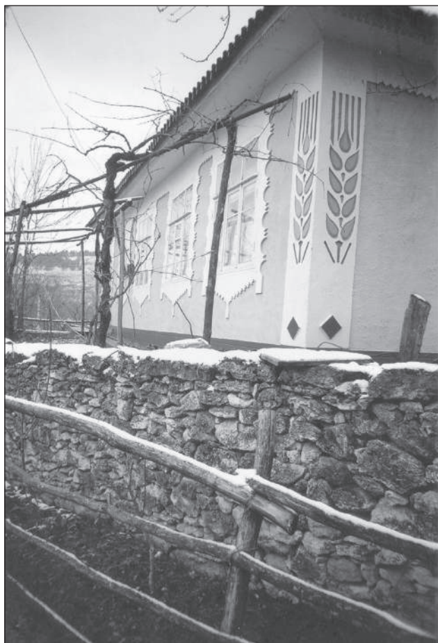
Фото 1. Угол дома из с. Хрустовая Каменского района, северная зона Приднестровья, резьба по штукатурке, роспись.
