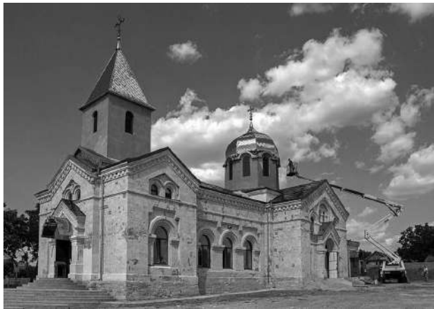
Освящённая в 1909 г. Карагашская церковь Казанской иконы Божьей Матери в ходе реставрационных работ июля 2020 г. (Фото А.А. Паламаря-старшего).
