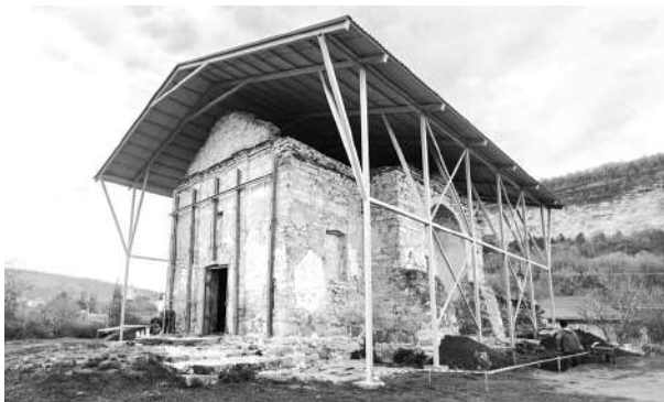
Покровская церковь с. Рашков в период проведения археологического исследования (октябрь – ноябрь 2022 г.). Для защиты от непогоды здание и прилегающие к нему участки поверхности покрыты защитным навесом
