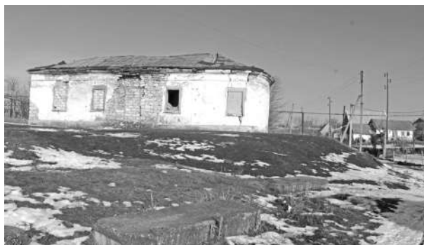
Заброшенная и постепенно разрушающаяся церковь св. Параскевы Сербской в с. Тея (снимок 2017 г., вид с юга). Лишенное в 1930-е гг. колокольни (стояла отдельно) и купола, здание долгое время выполняло функцию сельского клуба, а затем использовалось в качестве цементного склада
